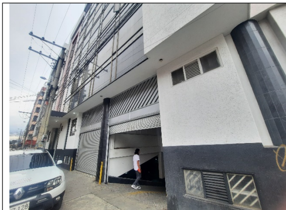
Foto No. 1 Fachada del predio
